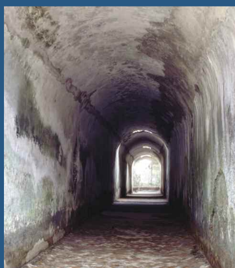
Interno di una delle cisterne della villa
